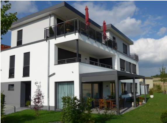
2017 Am tiefen Graben 27b in Niederkleen 3 Wohneinheiten
