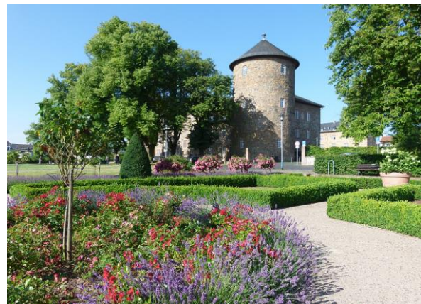
Schlossgelände in Butzbach
