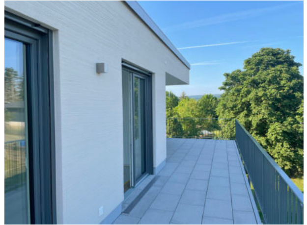
Beispielbild: Dachterrasse „H33“ Kirch-Göns
